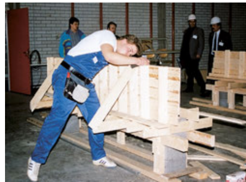
Rakennustekniikan kilpailussa kilpailijat rakensivat ensimmäisenä päivänä puusta teräsbetonipalkin muotin ja seuraavana päivänä raudoittivat palkin ja sen ulokkeen.
