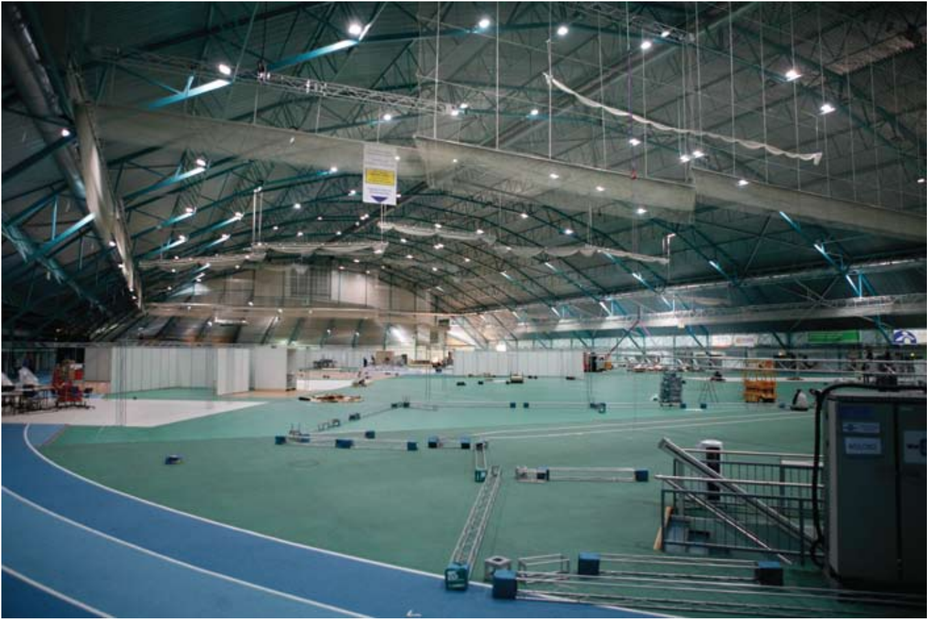
Lajialueiden rakentaminen alkoi 13.3.2009,
