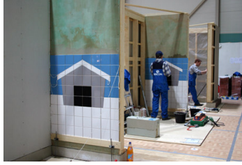
Rakentajan työ on monipuolista, se on mittaamista, rungon tekoa, muuraamista, laatoitusta jne.. Kultamitalin lajissa korjasi Seinäjoen ammattioppilaitoksen Niko Myllyniemi
