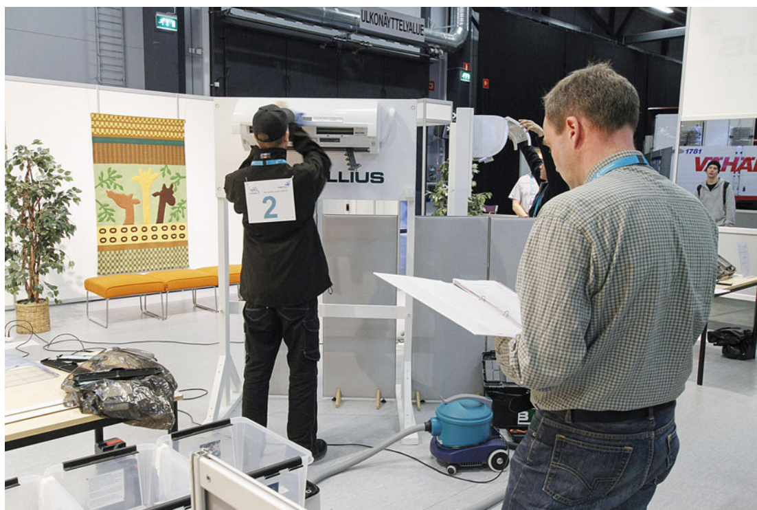
Ilmalämpöpumppua on puhdistamassa kilpailija Miika Valjakka. Työtä seuraa tuomari Harri Lyyra, Lassila-Tikanoja. Kuva Jarno Virtanen.
