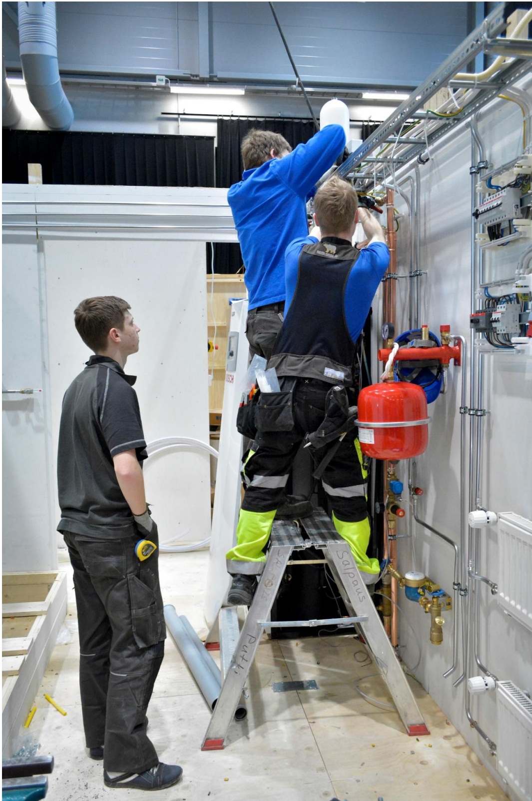
Sähkö- ja putkiasennuksen tehtävät samalla työmaalla
