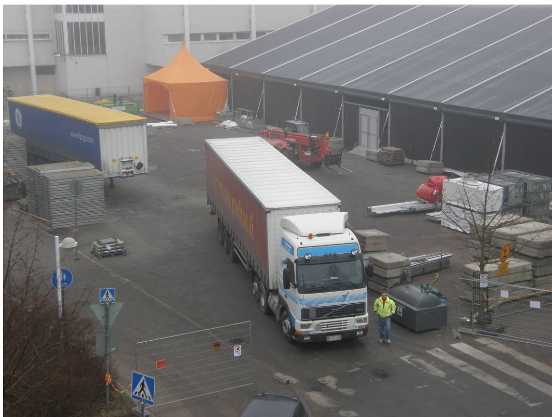
Tapiolan kulttuuriaukion tapahtuma-alueita puretaan (Kuva: Ari Toivonen)
