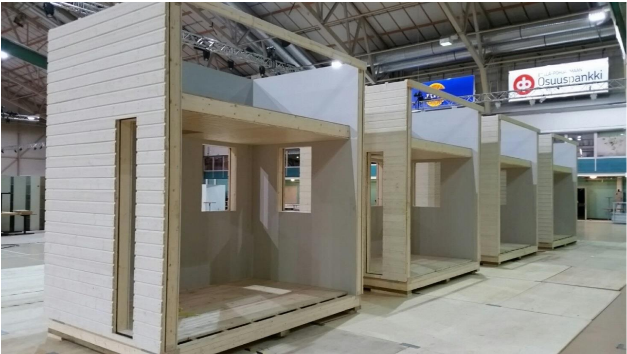
Kuva 1. Taitaja –moduulimökkejä odottamassa Maalaus ka tapetointi –lajin kilpailijoita tekemään pintakäsittelytehtäviä Taitaja2016 finaalissa Seinäjoki Arenassa. Kesällä samat rungot olivat valmiiksi märkeiksi jalostettuina Seinäjoen asuntomessualueen osastolla kävijöiden ihailtavina.
